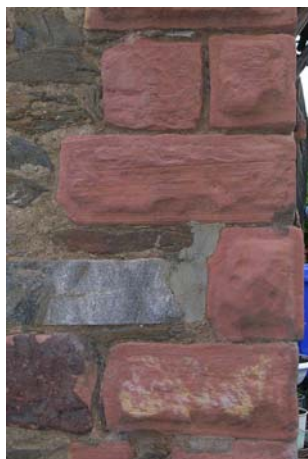
Abb.1: Bossierte Eckquader an der Scheune Spessartstraße 15
