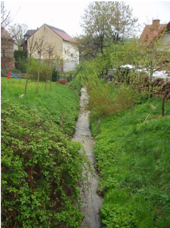
Schnepfenbach zwischen Spessartstraße und Freizeitgelände. Der Bach wurde im Zuge der Flurbereinigung begradigt und die Ufer befestigt
