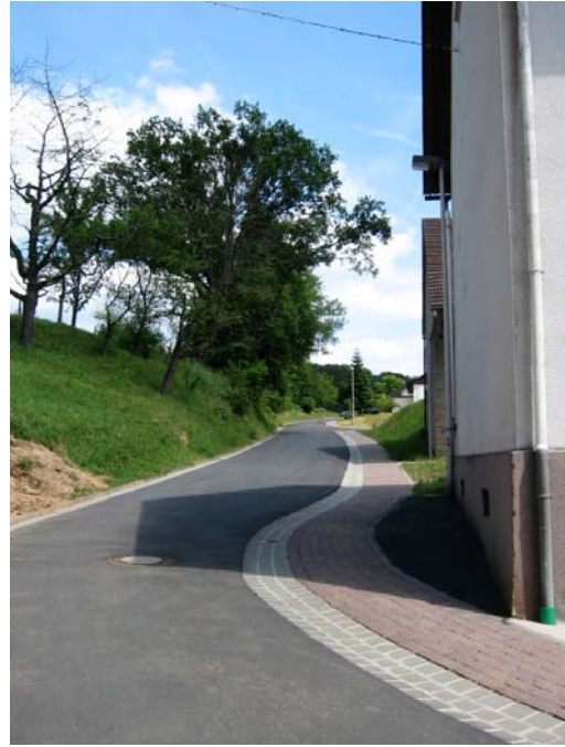
Neuer Straßenbelag und gepflasterter Gehweg in der Reingartenstraße.
