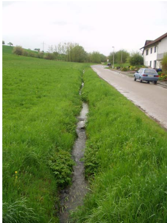
Strüttgrundgraben an der Flurstraße: In geradliniger Führung verläuft das Gewässer der Straße entlang.
