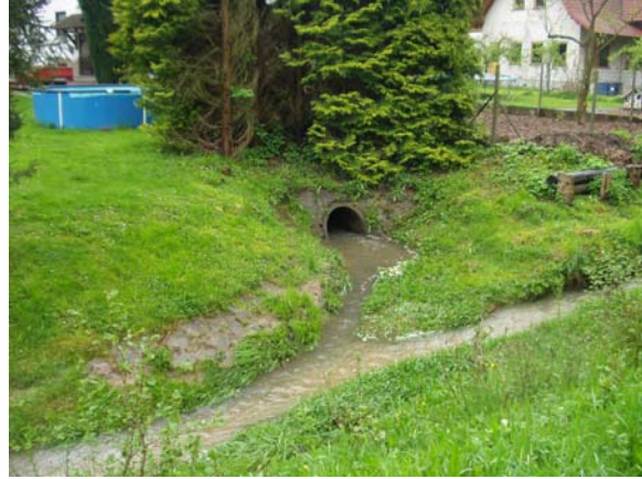
Schnepfenbach zwischen Spessartstraße und Freizeitgelände: Einmündung des verrohrten Strüttgrundgrabens
