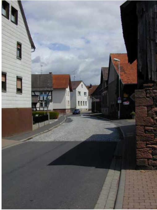
Enge Straßendurchfahrt in der Spessartstraße
