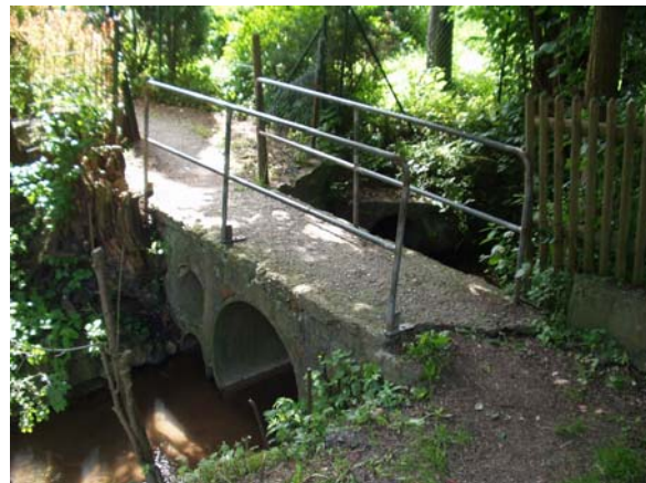
Brücke über dem Schneppenbach
